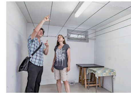
Energie-Coach Andreas Edelmann erklärt Nicole Burri, wie viel Energie die Genossenschaft einsparen kann, wenn die Kellerdecke gedämmt wird.
