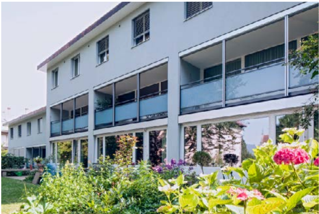
Wohnhaus Riesbach-Quartier: Neue Glasbrüstungen begrenzen Loggias. Fensterlaibungen im Obergeschoss, Dachvorsprung und Zwischenwände der Loggias zeichnen mit der 14 cm Isolationsschicht die Gebäudestruktur stärker nach als zuvor.
