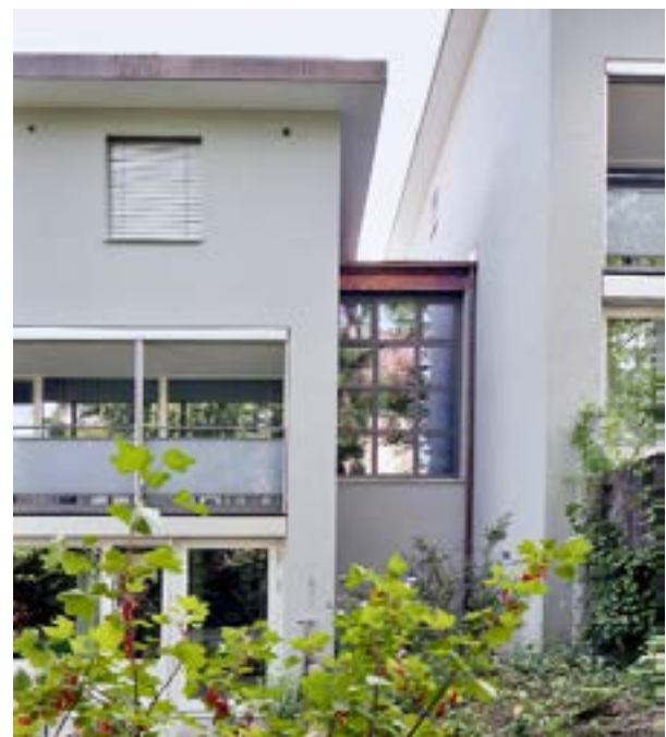
Das Treppenhaus erhielt anstelle der alten, mit einzelnen Betonrahmen unterteilten Einfachverglasungen ein raumhohes Isolierglasfenster.
