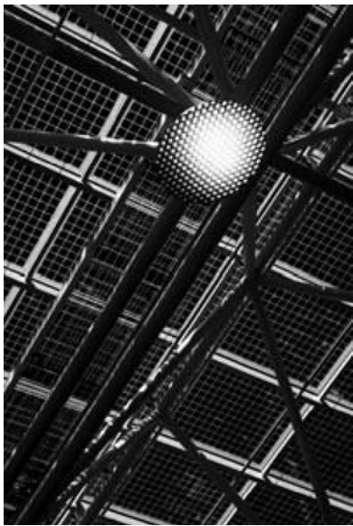
Titelbild: Die Isolierglasintegrierte Photovoltaik-Anlage auf dem Vordach der Migros am Limmatplatz in Zürich produziert 50'000 kWh Elektrizität im Jahr! (Foto: Simone Vogel)
